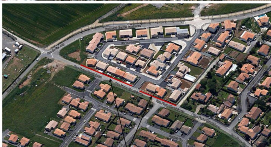
Mur de soutènement des riverains
