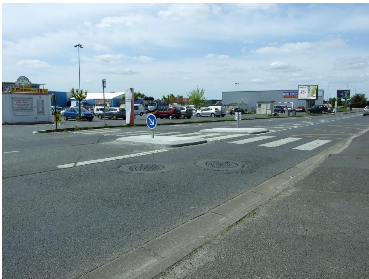
Ilot de protection des piétons, Route d'Aiffres, réalisé en régie au printemps 2018.
