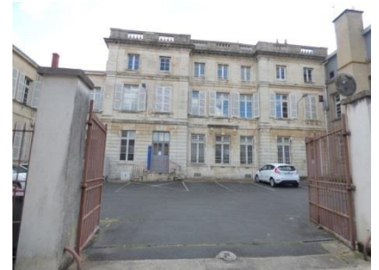
La Poste – bâtiment rue Dupin
