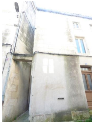
Marquage de l'entrée Rue Saint-Maixent
