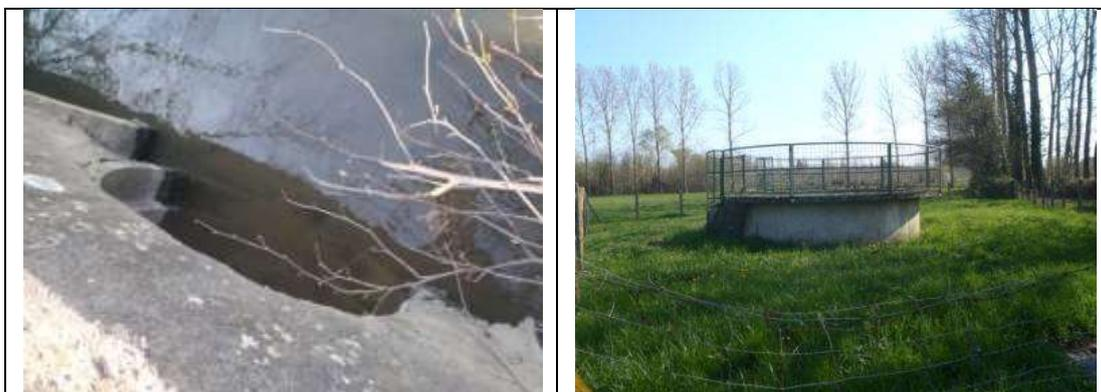
**Figure 2 : Prise d'eau et dégrillage**
