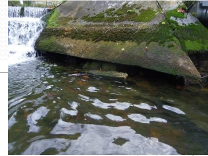
Détail des dégradations autour des vannes
