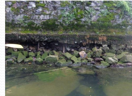
Détail des dégradations autour des vannes
