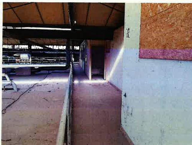
Vue du plancher
