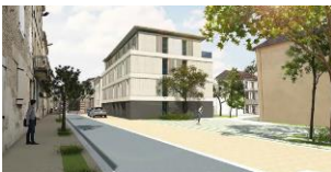
A25) Site Denfert-Rochereau-Immeuble tertiaire et France Service
